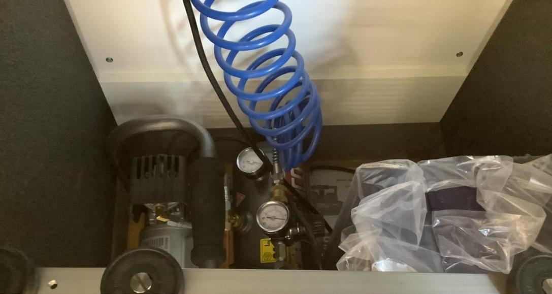
**Fest installierter Hochleistungskompressor zur Bereitstellung von Druckluft für alle Laborwandzeilenarbeitsplätze**
